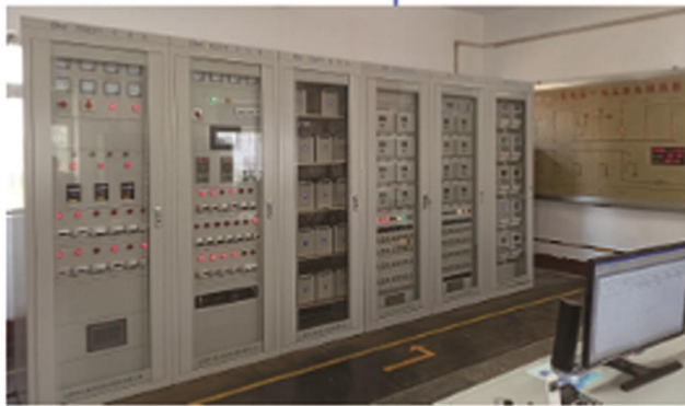
集中式安装的保护装置
